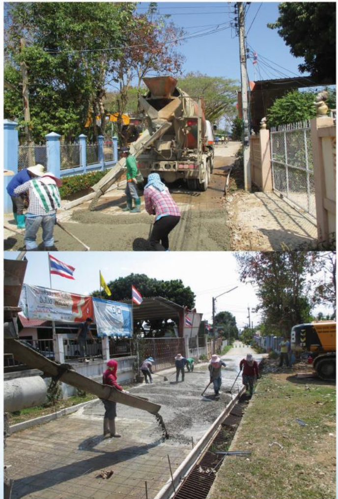
ก่อสร้างถนนคอนกรีต
