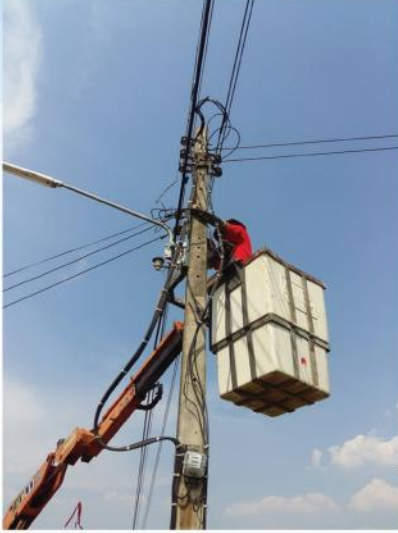
ซ่อมแซมไฟฟ้าสาธารณะ ไฟกิ่ง
