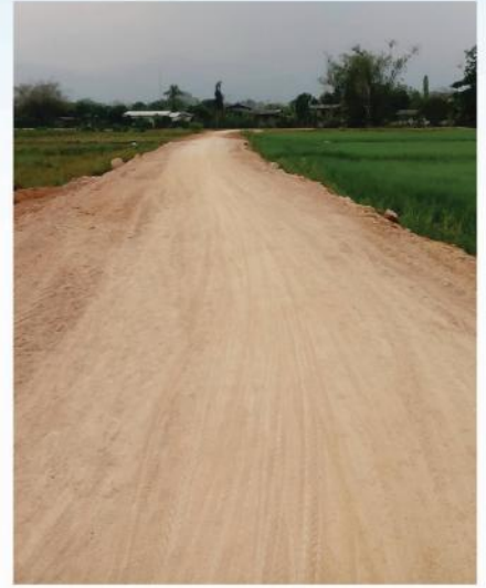
ก่อสร้างถนนดินลูกรังเข้าพื้นที่การเกษตร
