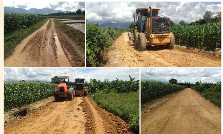
โครงการก่อสร้างถนนลูกรังบดอัด หมู่ที่ 9 สายใต้เชื่อม หมู่ที่ 5
